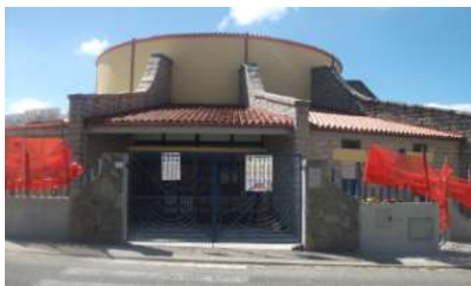
Asilo in via Fabrizio De Andre
